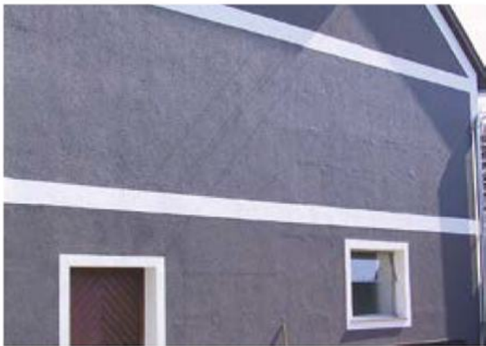
Видимая деформация в месте применения полистирола, вызванная воздействием высокой температурой
